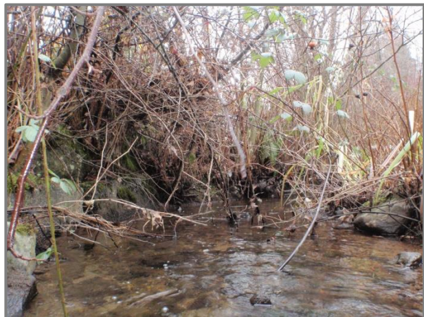
Downstream Conduit Picture
